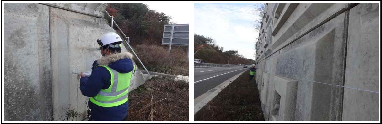
【그림 5.3.6】 슈미트해머를 이용한 반발경도시험 전경
